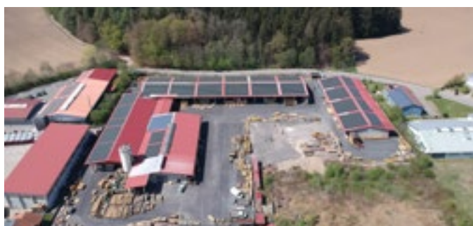
Holzwerk Kübler | Amtzell 749 kWp | SolarEdge Technik
