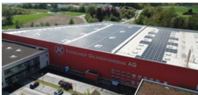
Kässbohrer Geländefahrzeug AG | Laupheim 749 kWp | SolarEdge Technik
