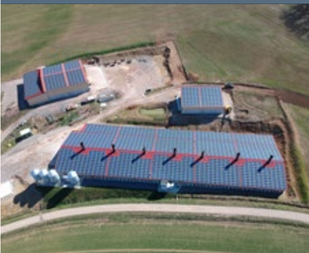
Landwirtschaftliche Anlage | Bad Mergentheim 492 kWp
