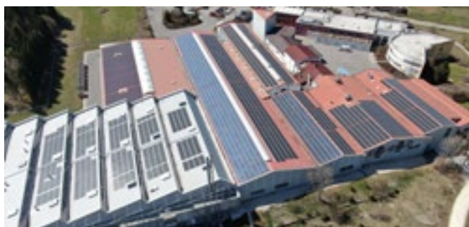
ALB-GOLD Teigwaren GmbH | Trochtelfingen 705 kWp | SolarEdge Technik
