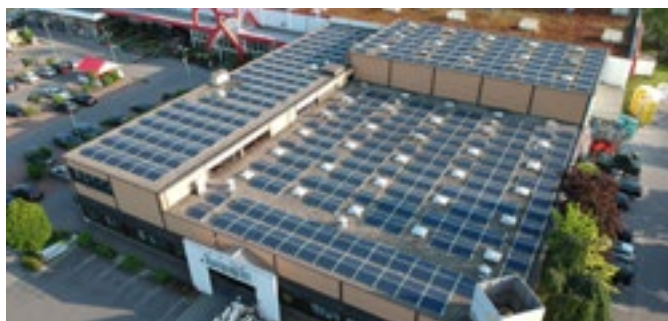
Thommel Hausrat | Ravensburg 195 kWp | SolarEdge Technik
